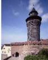
NbgKbg.I, Sinwellturm u. Schildmauer, DE001393, BSV-
