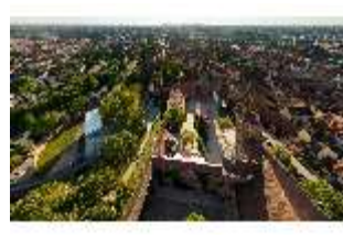
NbgKbg.I, Luftaufnahme von W, DI026136, BSV-
