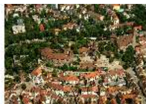
NbgKbg.I, Luftaufnahme Kaiserburg, DI016639, BSV-
