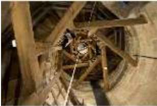
NbgKbg.II, Sinwellturm, Treppe, DI000505, BSV
