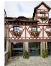
NbgKbg.I, neuer Kassenbereich (Kastellansgebäude), DI020529, BSV
