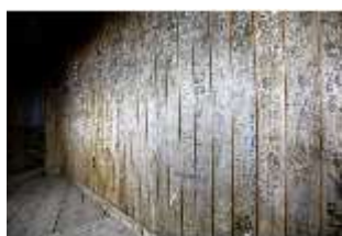
NbgKbg.II, Sinwellturm, Ausstiegshäuschen, DI000904, BSV
