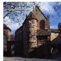
NbgKbg.I, Burgamtmannsgebäude (21), DE001396, BSV
