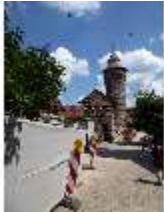
NbgKbg.I, Blick auf den Sinwellturm und Brunnen, 2016, DI006275, BSV-
