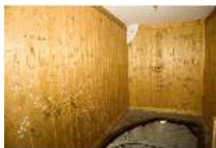
NbgKbg.II, Sinwellturm, Ausstiegshäuschen, DI000900, BSV
