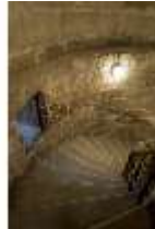
NbgKbg.II, Sinwellturm, Treppe, DI000503, BSV
