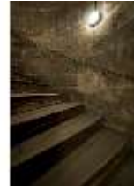
NbgKbg.II, Sinwellturm, Treppe, DI000504, BSV
