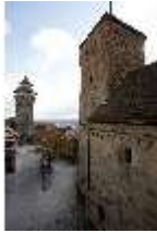
NbgKbg.I, Sinwellturm und Heidenturm, DI021009, BSV
