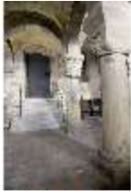
NbgKbg.II, Margaretencapelle, Blick Richtung Norden, DI000920, BSV
