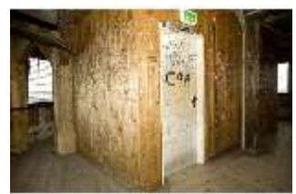
NbgKbg.II, Sinwellturm, Ausstiegshäuschen, DI000902, BSV
