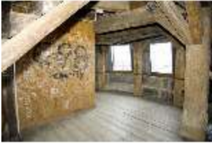
NbgKbg.II, Sinwellturm, Ausstiegshäuschen, DI000907, BSV
