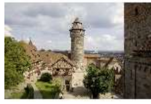
NbgKbg.I, Blick auf den Sinwellturm und Brunnen, DI000443, BSV
