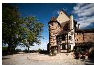
NbgKbg.I, Burgamtmannsgebäude/Burgamtmannswohnung, DI026256, BSV-
