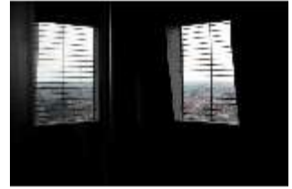
NbgKbg.II, Sinwellturm, Blick auf zwei Fenster, DI000499, BSV
