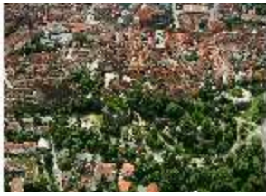
NbgKbg.I, Luftaufnahme Kaiserburg, DI016641, BSV-
