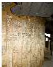
NbgKbg.II, Sinwellturm, Ausstiegshäuschen, DI000903, BSV
