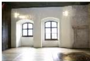
NbgKbg.II, Kammer des Kaisers (5), Blick Richtung Süden, DI000924, BSV
