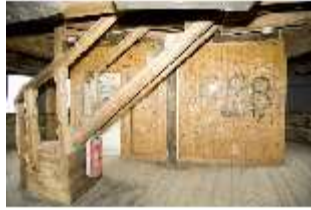
NbgKbg.II, Sinwellturm, Ausstiegshäuschen, DI000908, BSV
