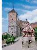
NbgKbg.I, Heidenturm, Kaiserkap. u. Brunnenhaus, DE000306, BSV-
