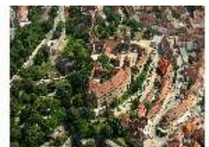
NbgKbg.I, Luftaufnahme Kaiserburg, DI016640, BSV-
