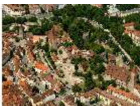
NbgKbg.I, Luftaufnahme Kaiserburg, DI016638, BSV-
