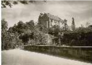
NbgKbg.I, Westgiebel nach Instandsetzung, DE004139, BSV
