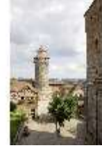
NbgKbg.I, Blick auf den Sinwellturm und Brunnen, DI000444, BSV
