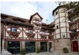
NbgKbg.I, neuer Kassenbereich (Kastellansgebäude), DI020529, BSV
