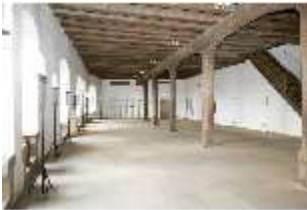
NbgKbg.II, Ritteraal (1), Blick nach Nordwesten, DI000891, BSV
