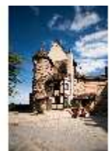
NbgKbg.I, Burgamtmannsgebäude/Burgamtmannswohnung, DI026255, BSV-
