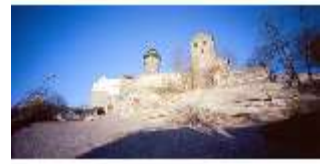
NbgKbg.I, Walburgiskapelle, Sinwellturm, DE001398, BSV
