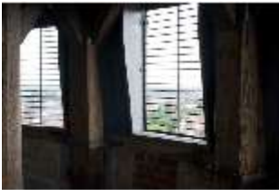
NbgKbg.II, Sinwellturm, Blick auf zwei Fenster, DI000497, BSV
